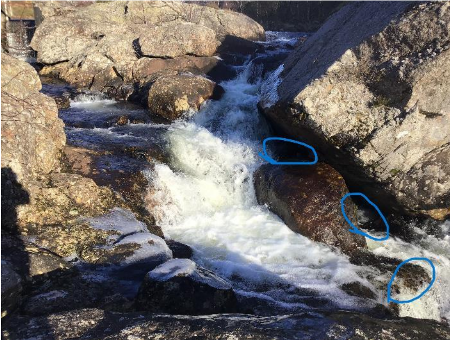
Figur 48. Ved 3 kan det være aktuelt å fjerne noe utstikkende berg (høyre), samt å tette vannvei bak blokk.
