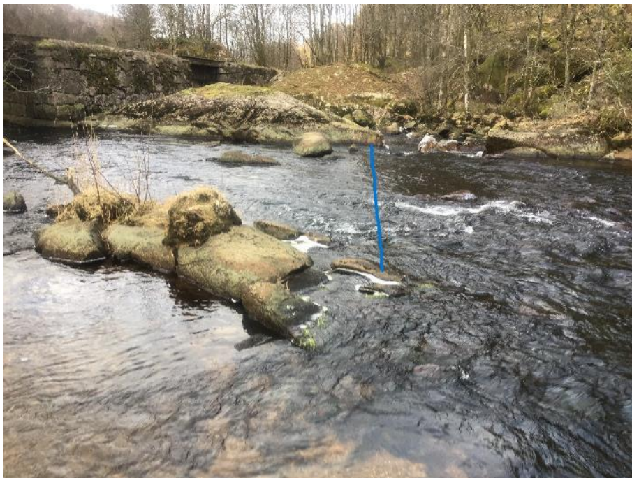
Figur 44. Linja er antatt beste sted å lede vann over mot vestre løp under arbeidet. Det er aktuelt å bruke storsekker med vasket gytegrus her til dette. Gytegrus skal senere benyttes i prosjekt i Ålgårdselva. Det er viktig at tiltaket gjennomføres på lav vannføring. I dette området er det også aktuelt å vurdere flytting av noen blokker for å gi østre løp og vandringsveier noe mer vann ved lavere vannføringer.
