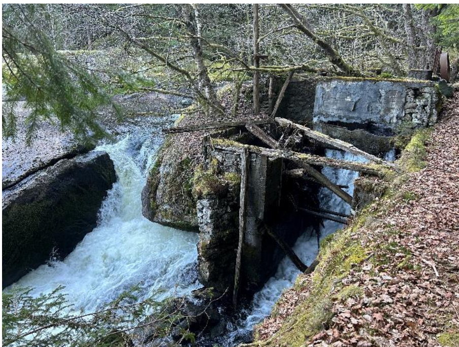
Figur 32. Toksafossen er en lav foss som delvis renner under ei stor steinblokk. Bildet er tatt på en vannføring på 850 l/s (Refsvatnet). Vannet renner delvis via rester av gammelt kraftverk. I øvre del av landingsplass i det smale fosseløpet er det utstikkende steinblokker/berg i 1/3 av løpsbredden. Dette utgjør en hindring for fisken ved sprang, og utgjør en risiko for skader.
