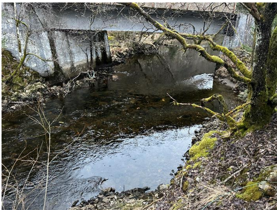
Figur 58. Tiltaksområde 1 sett fra sørøstsida av brua.
