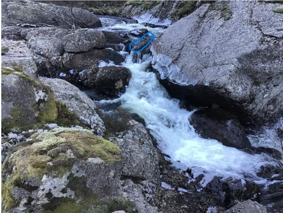
Figur 50. Stor utstikkende blokk som bør fjernes.
