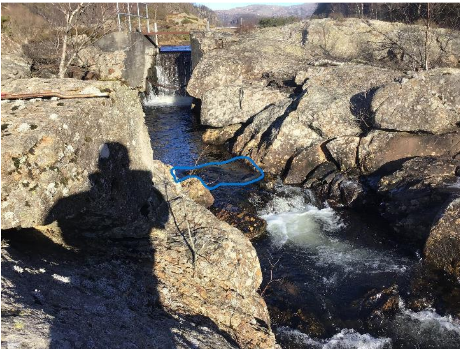
Figur 49. Markering ved punkt 4 hvor en liten steinterskel bør etableres, for å unngå at fisken vandrer inn blindveien mot reguleringsluka. 80 cm høyde er trolig tilstrekkelig.
